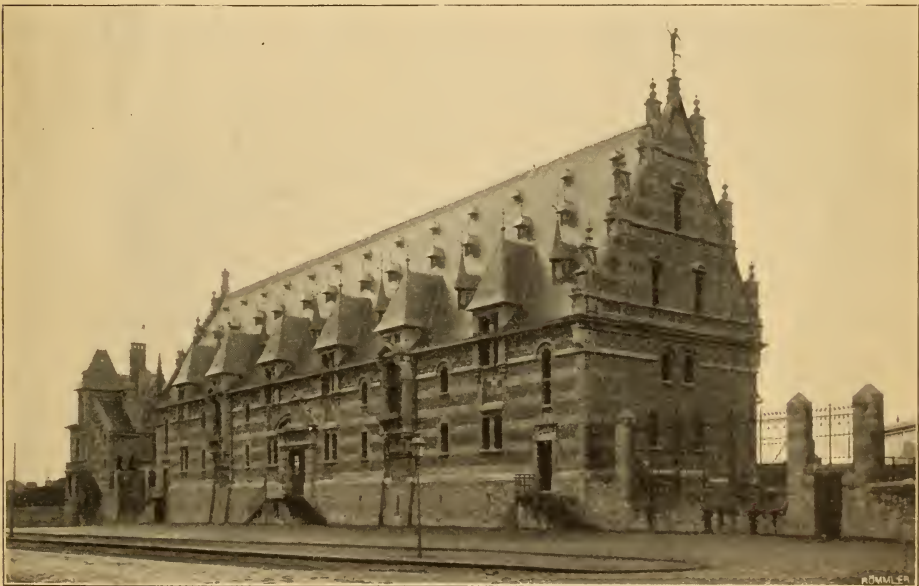
Abb. 120. Das Packhaus im Bahnhof.
